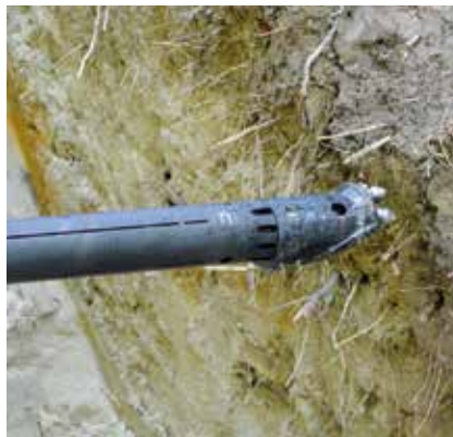
Einsatzbereit für die Pilotbohrung: Vorbohren für den störungsfreien Rohreinzug bis 200 mm Durchmesser.
