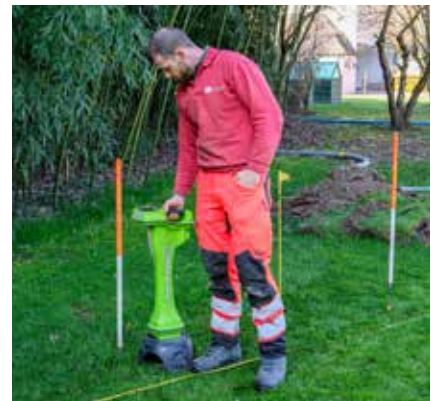
Der im Bohrkopf integrierte Sender ermöglicht dem Bohrergerätführer die permanente Kontrolle von Tiefe, Position und Winkel.
